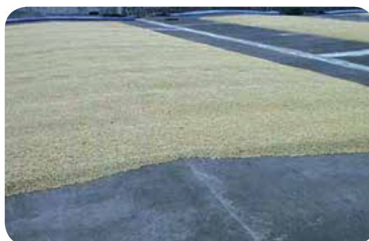
Hình 2. Sân có gờ "sống trâu" ở giữa, dốc nhẹ về 2 phía; nước thoát dễ dàng khi trời mưa
